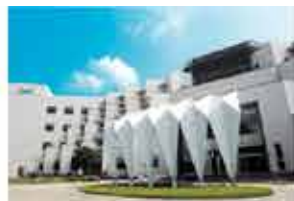
台南研發中心 (鑽石級綠建築)
