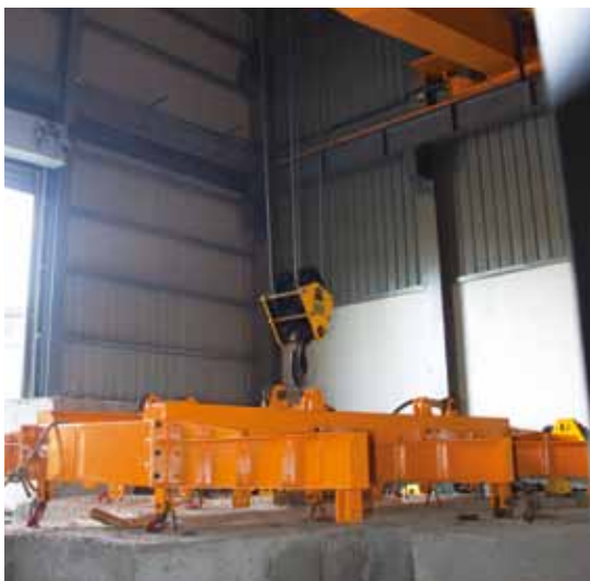
Load Testing ( 測試荷重台 )
