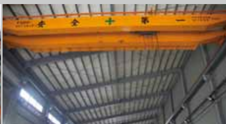
台灣優強 A/B 廠房 Factory Overview -Site A & Site B
