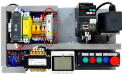
採用混合式馬達啟動器，尺寸縮減 75% 配線速度：3 分鐘→ 12 接線點
